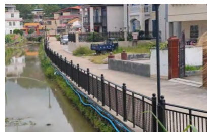
广东双坑村防护栏修建
