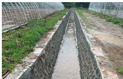
北京密云山口庄村防洪渠修建
